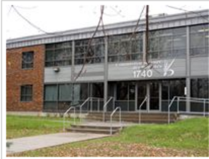
Les travaux au siège social de la Commission scolaire des Patriotes devraient se faire durant l'été. Photo: Agence QMI
